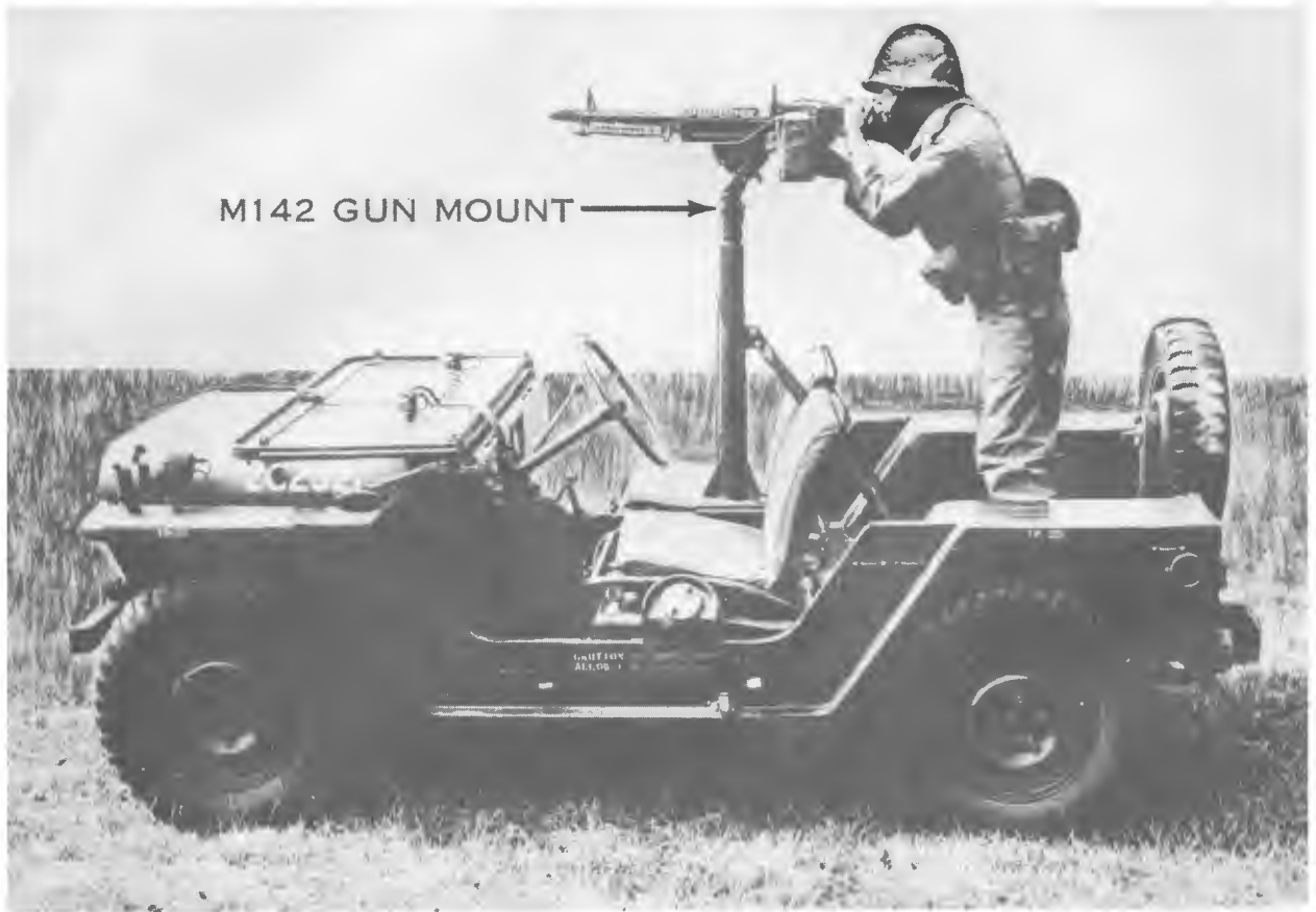
Figure 39. M4 pedestal mount.
